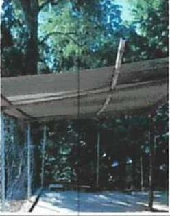
Sustitución de madera por estructura de metal en el patio, utilizando costanera de 2"x4", tubo de 6"x2" y lámina acanalada calibre 26 legítima.
